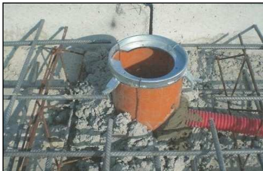
Fot. 1. Widok studni montażowej.
